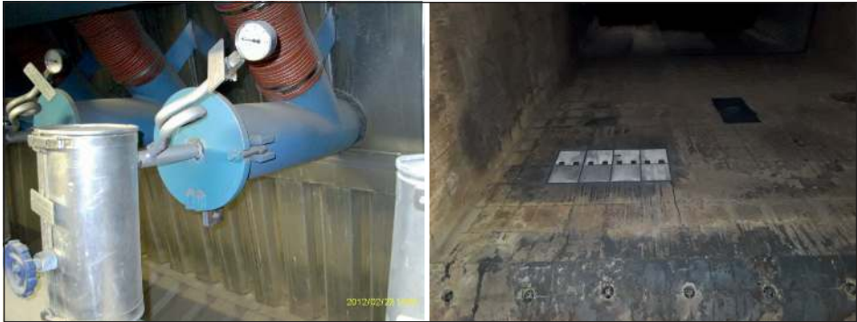
Bild 5: Ausführung eines Doppelstrahl-Sekundärluft-Systems mit Überschall-Dampf (Boostersteam)
