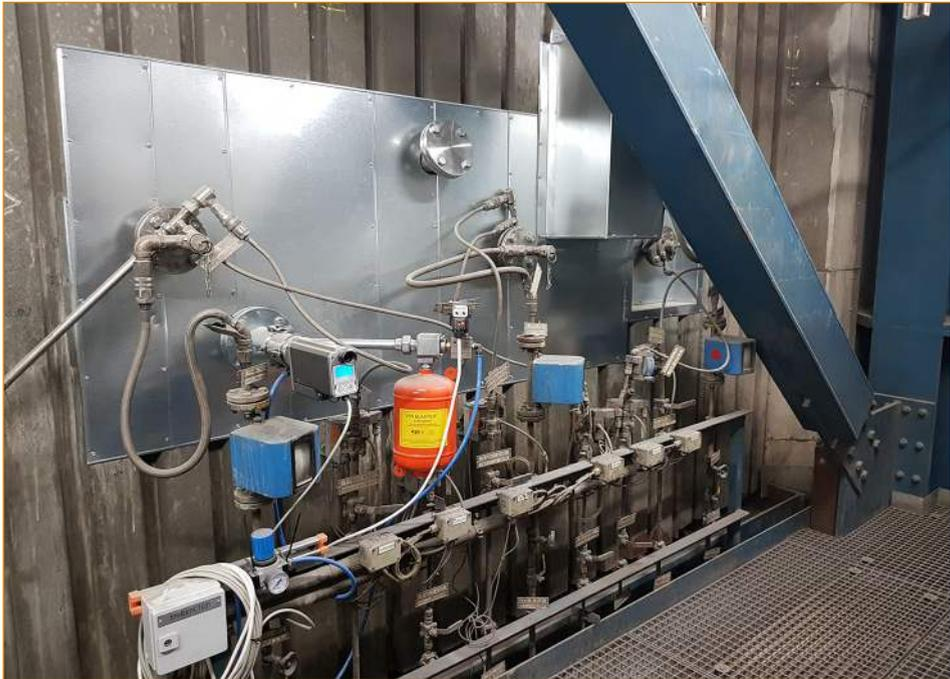
Bild 4: SNCR-System alt und neuer Stutzen sowie neue Temperaturmessung (Pyrometer)
