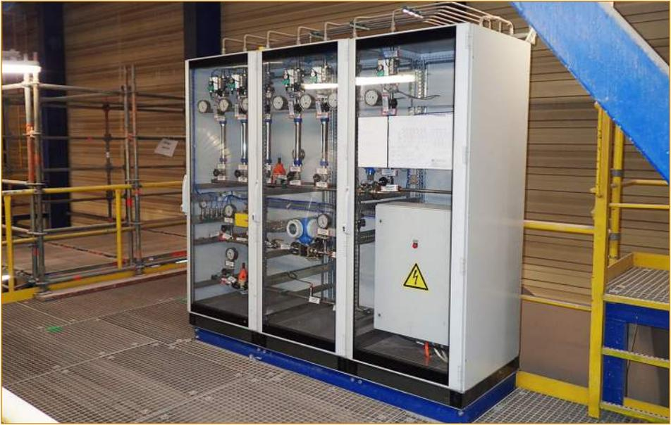
Bild 7: Misch- und Regelmodul für die Ansteuerung der Lanzen im Bereich der Eindüsebene auf 41 m der Anlage Schwedt
